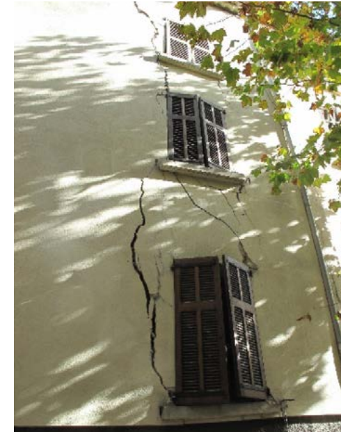
Fissures sur les bâtiments dans le village de Bargemon © BRGM
