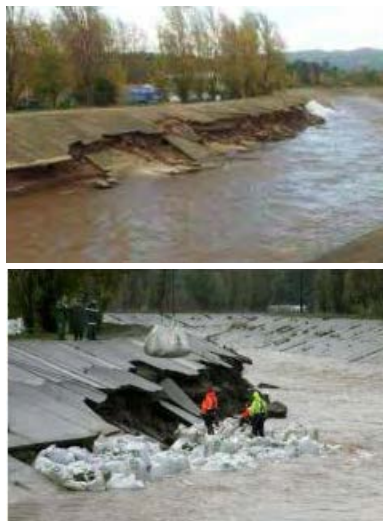
Désordre sur la digue rive droite du Reyran en 2011. Source DDTM83
