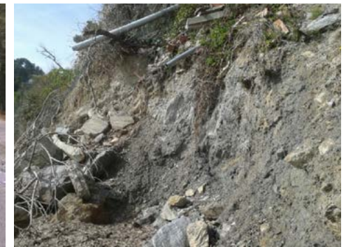
Glissement de terrain dans les phyllades altérées du Pin de Galles au Pradet © BRGM
