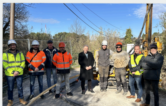
Travaux pont de la Portanière 19 mars
